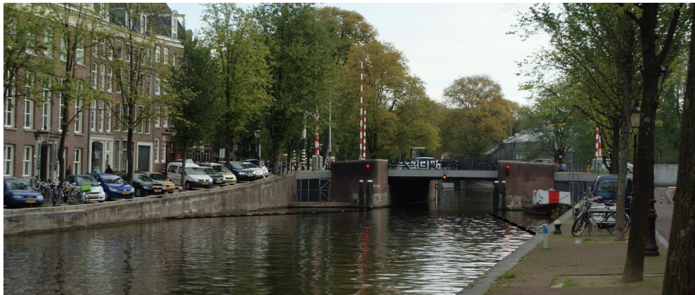
Figuur 4 Impressie van de maatregelen bij brug 238 (bron Urban Life, 2013)
