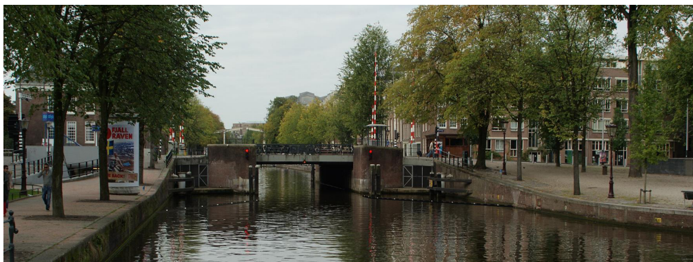
Figuur 5 Impressie van de maatregelen bij brug 238 (bron Urban Life, 2013)
